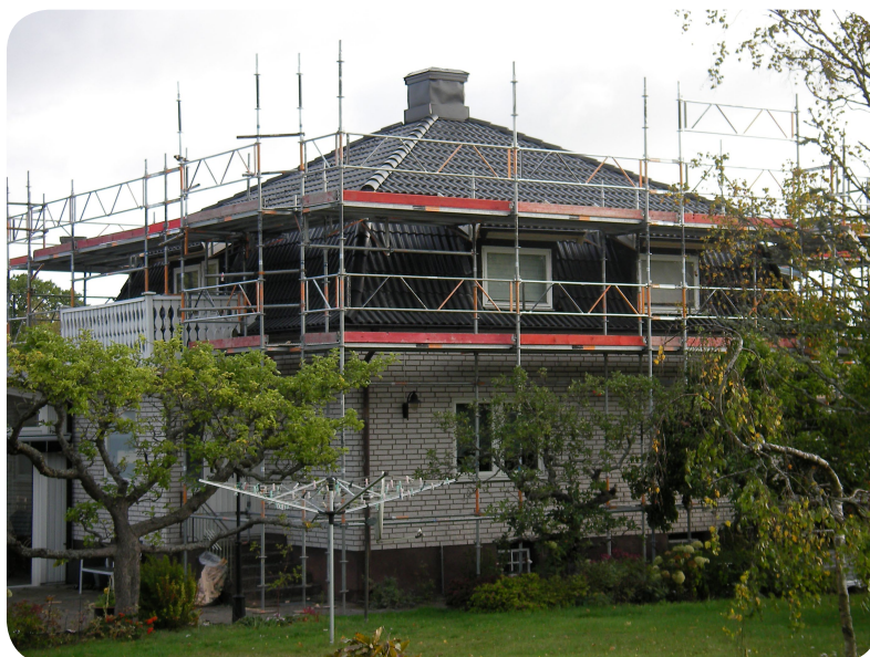
Takbyte på Blomlöfs gamla hus
